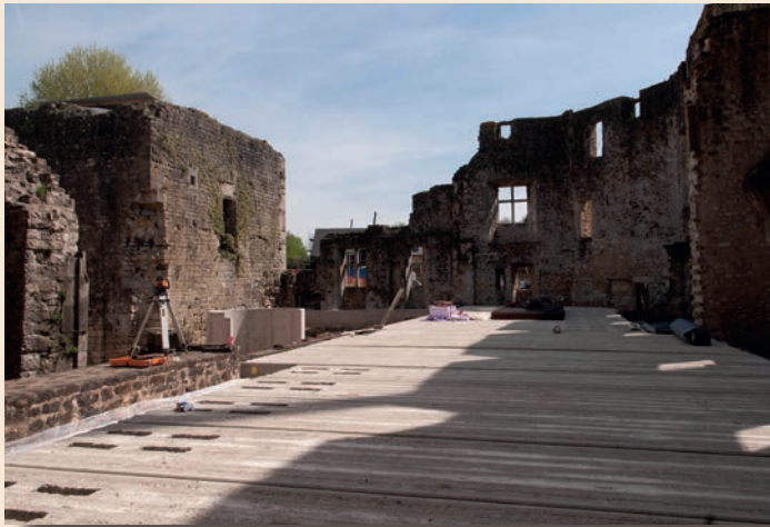
Avril 2018 : Un nouveau plancher pour l'ancien bâtiment principal
