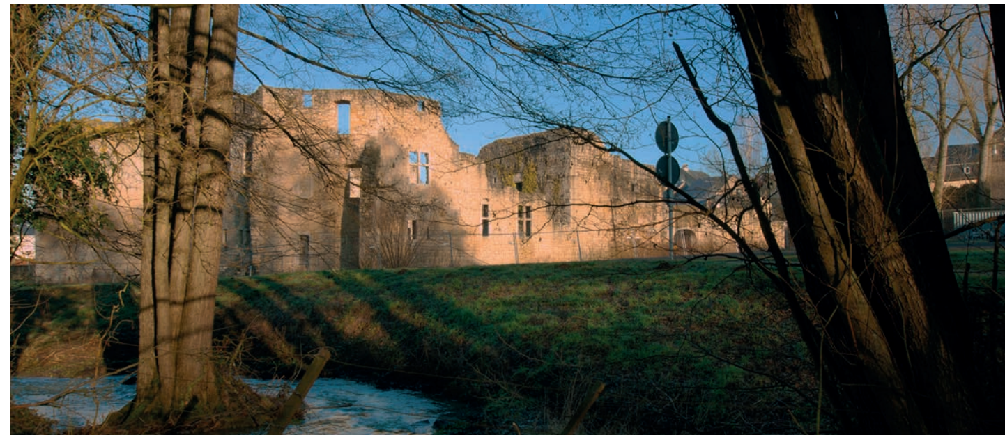
Vue du ruisseau de Goebloge sur la façade côté Est du Gréiweschlass
