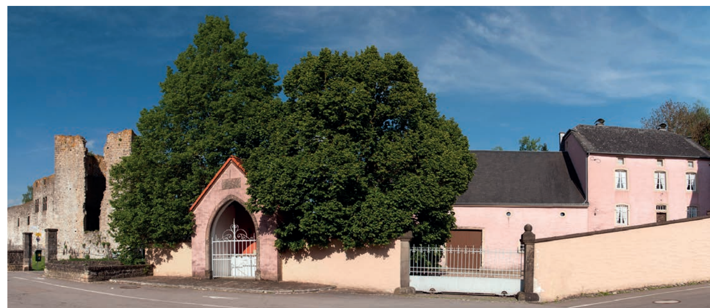
Entrée sud-ouest vers le Gréiweschlass
